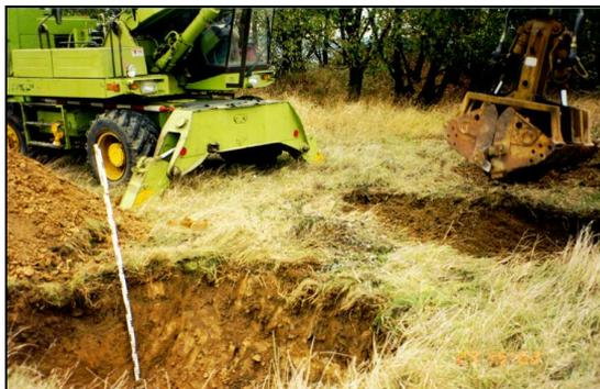
d) Aushub von 2 Gruben: Grube 1 mit Sand- und Ziegelschuttfüllung (schwermetallfreies Material)
