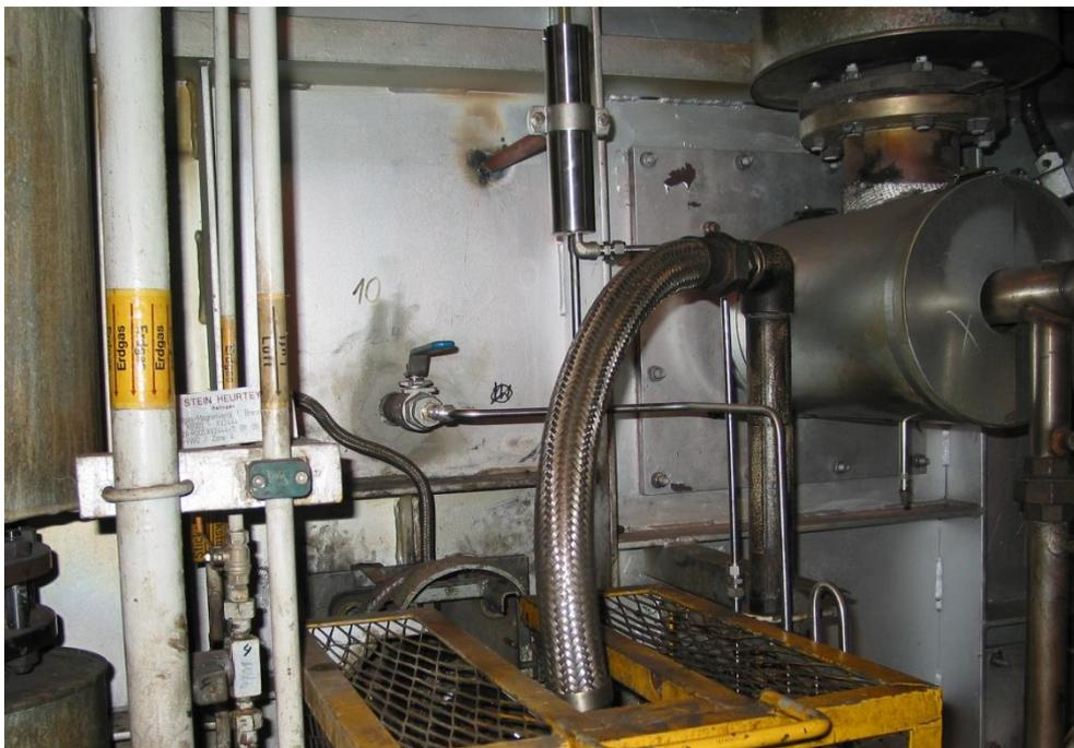
**Abbildung 4-3:** Fotografische Ansicht einer Probennahmemessstelle mit eingebauter Probennahmesonde am Vorwärmofen (Stranzinger, B.; Giese, R.; Mintus, F.; u.a. (2011))
