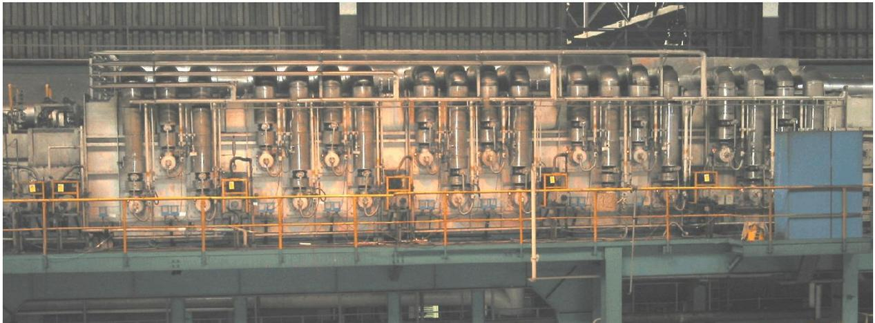
**Abbildung 2-3:** Fotografische Ansicht des untersuchten Vorwärmofens der Feuerverzinkungsanlage (Stranzinger, B.; Giese, R.; Mintus, F.; u.a. (2011))
