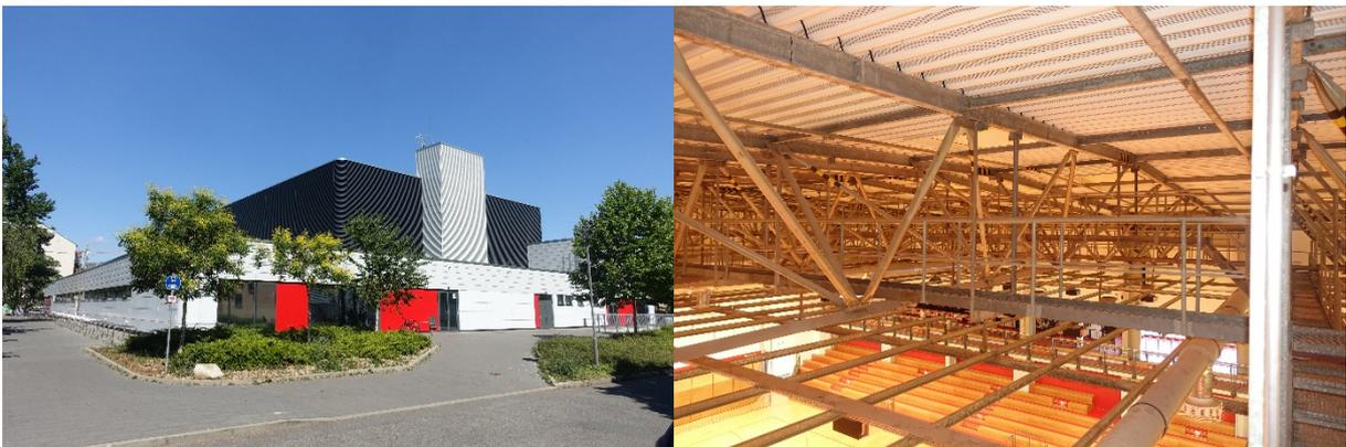
Abb. 25 und 26: Die Sporthalle in der Leipziger Brüderstraße ist eines der wenigen Exemplare des Typs ‚RGW‘. Mit Anbauten ergänzt heute eine beliebte Ballsportthalle. Das Tragwerk ist ein ‚RTR‘-Dreigurtbinde und ist in vier vorgefertigten Segmenten auf die Stützen gesetzt worden. Foto: Volker Mende, 2022.
