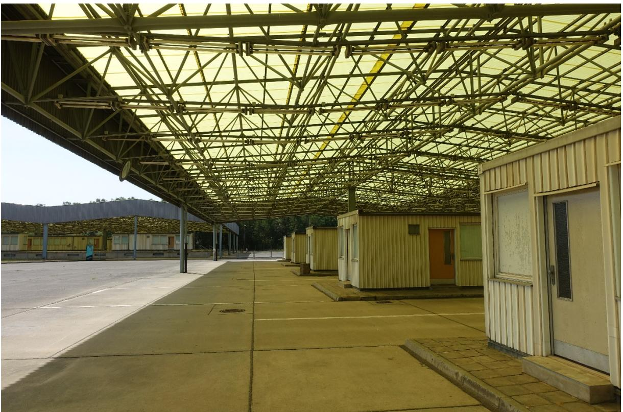
Abb. 8: Die Grenzübergangsstelle Marienborn, Denkmal der deutschen Teilung, zeigt die eindrucksvolle Wirkung des Stabnetztragwerkes ‚Typ Berlin‘ als Schutzdach. Foto: Volker Mende, 2022.
