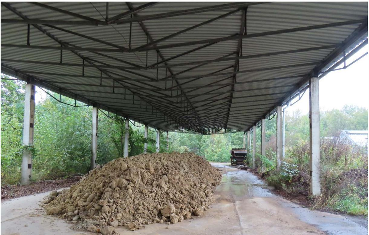
*Abb. 11: Ebenfalls für den Export, daher im Inland in höchstem Maße selten, wurde das ‚Unterspannte Blechdach‘ entworfen. Die EKOTAL-Dachhaut ist unter Spannung auf die leichten Binder geschraubt und wirkt als Obergurtscheibe. Hier ein Exemplar in Cottbus. Foto: Volker Mende, 2023.*
