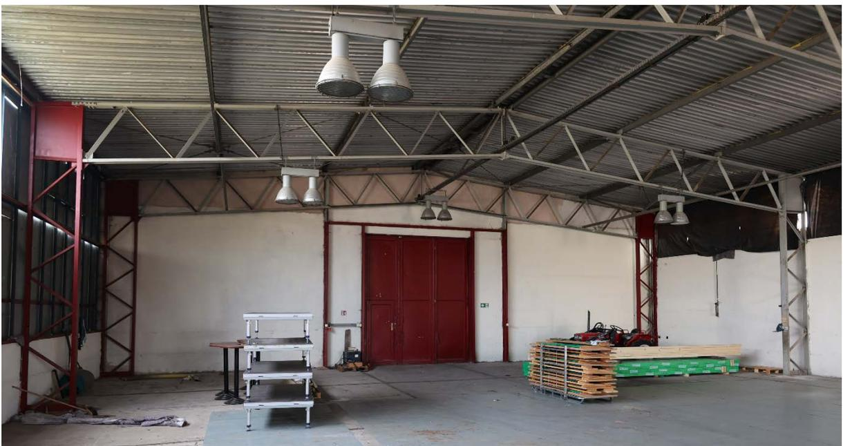
*Abb. 30: In Magdeburg ist 2023 diese ‚Fachwerkrahmenhalle KTS‘ demontiert und eingelagert worden. Vor und während des Rückbaus hat unser Projekt das Bauwerk fotografisch dokumentiert. Der korrosionsträge Stahl ist 1983 bauzeitlich grau gefasst worden, die weinrote Fassung stammt von nach 1990. Foto: Volker Mende, 2022.*
