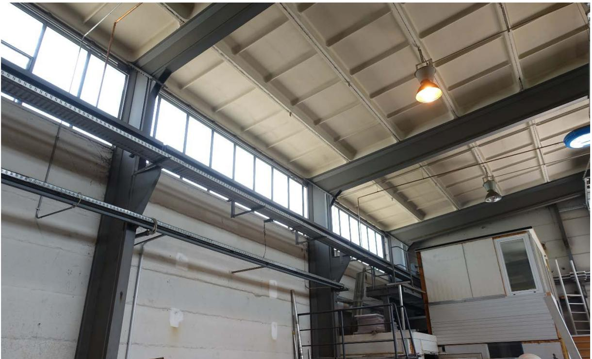
Abb. 15: Mit seinem klaren Mittelsteg ist der ‚Rahmenbinder II‘, auch ‚Plauen II‘ deutlich von seinem Vorgänger zu unterscheiden, diese Variante als Warmdach mit pfettenlosem Verbunddach nutzt ein mittelständischer Betrieb in Freiberg. Foto: Volker Mende, 2021.
