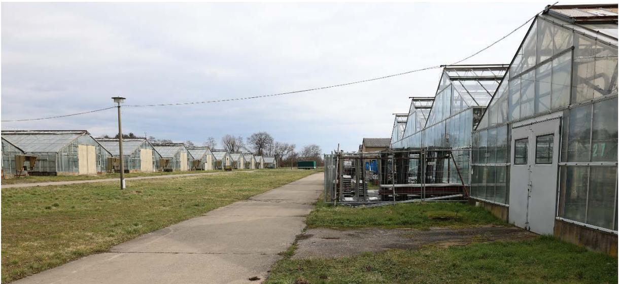
Abb. 17: An der Großgewächshausanlage in Radebeul kann man fast die gesamte Entwicklung der Gewächshausstypen der DDR studieren, rechts das ,TG 10' mit Isolierglasscheiben. Foto: Volker Mende, 2023.
