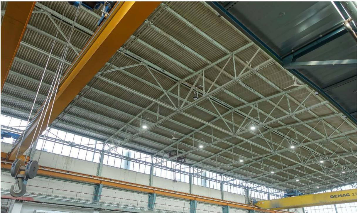
Abb. 9: Leichter Fachwerkbinder mit Kaldach der Korrosionsschutzhalle des vormaligen Werkes Magdeburg des MLK. Foto: Volker Mende, 2022.
