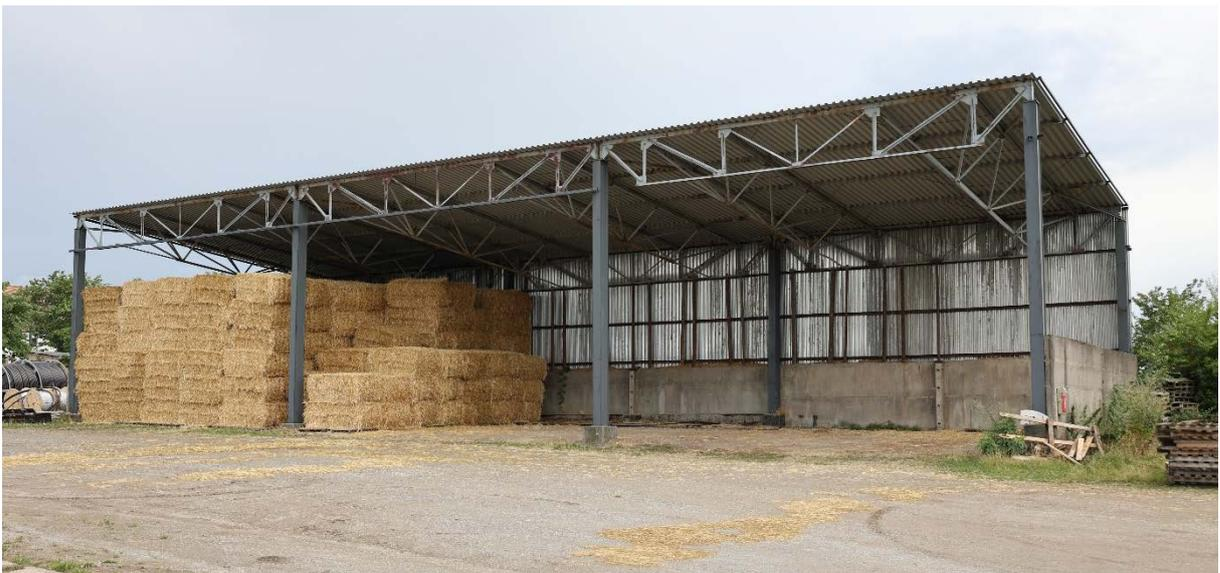
Abb. 18: Halboffene Strobergehalle im Elbsandsteingebirge, extrem verschlanktes Dreigurttragwerk mit EKOTAL-Deckung. Foto: Volker Mende, 2023.
