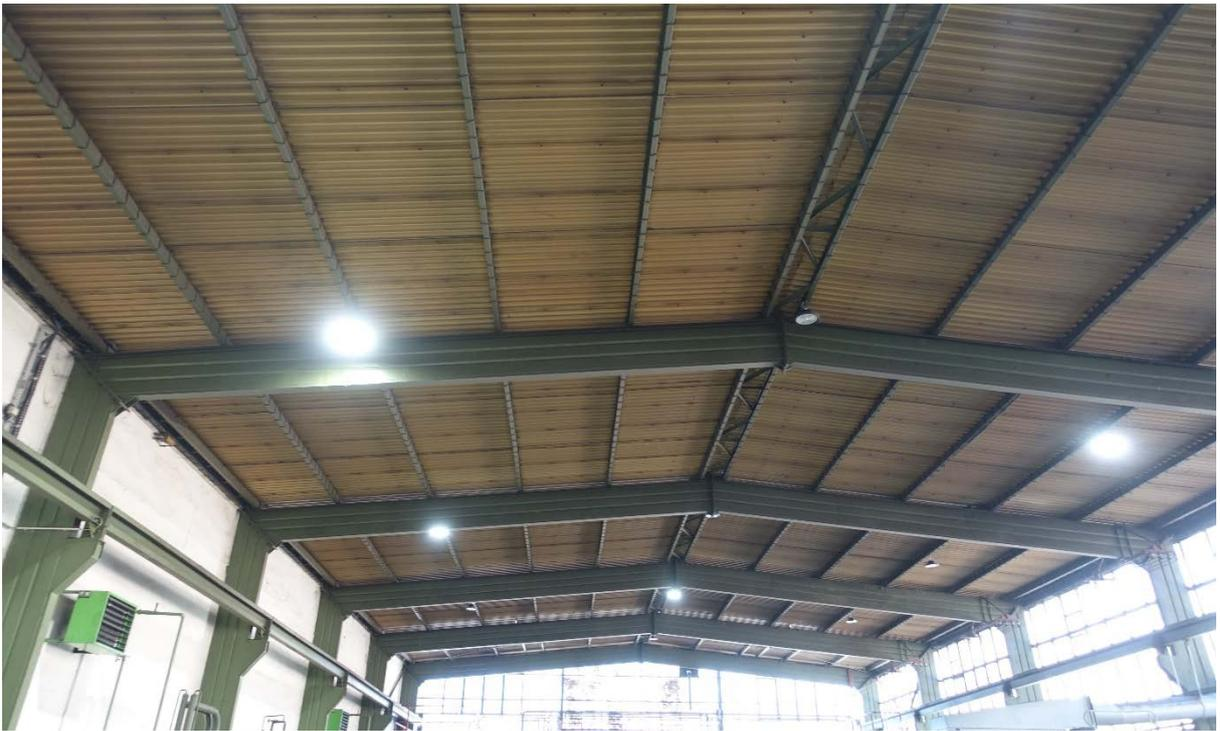
Abb. 14: Unverkennbar ist der ‚Rahmenbinder I‘, auch ‚Plauen I‘ genannt, deutlich sind die Längssicken erkennbar, hier in Burg bei Magdeburg. Foto: Volker Mende, 2023.
