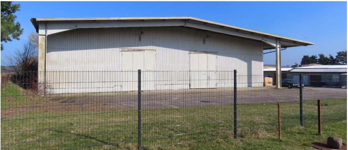
*Abb. 10: Mit dem Exportprodukt ‚Rahmen 80‘ konnte das MLK Anschluss an die internationale Entwicklung nehmen. Um so bedeutsamer ist dieser einmalige Fund einer ‚R 80‘-Halle im Inland, welche 1988 für ein Agrochemisches Zentrum nahe Lutherstadt-Wittenberg errichtet wurde. Foto: Volker Mende, 2024.*
