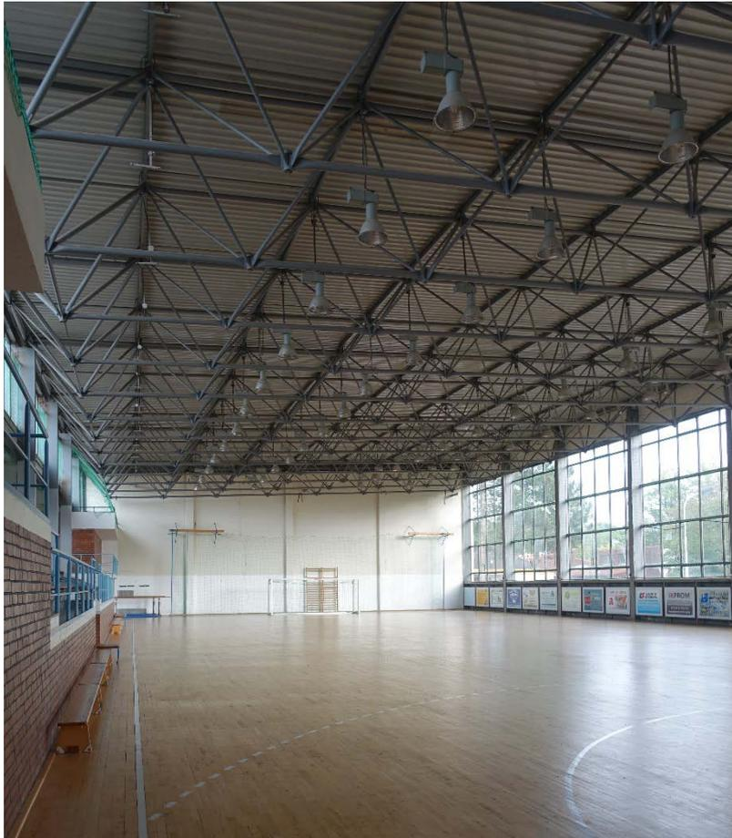
Abb. 7: Das räumliche Stabnetztragwerk ‚Typ Berlin‘ überbrückt große Flächen stützenfrei. Weiter in Nutzung ist die Sporthalle in Tangerhütte. Foto: Volker Mende, 2022.
