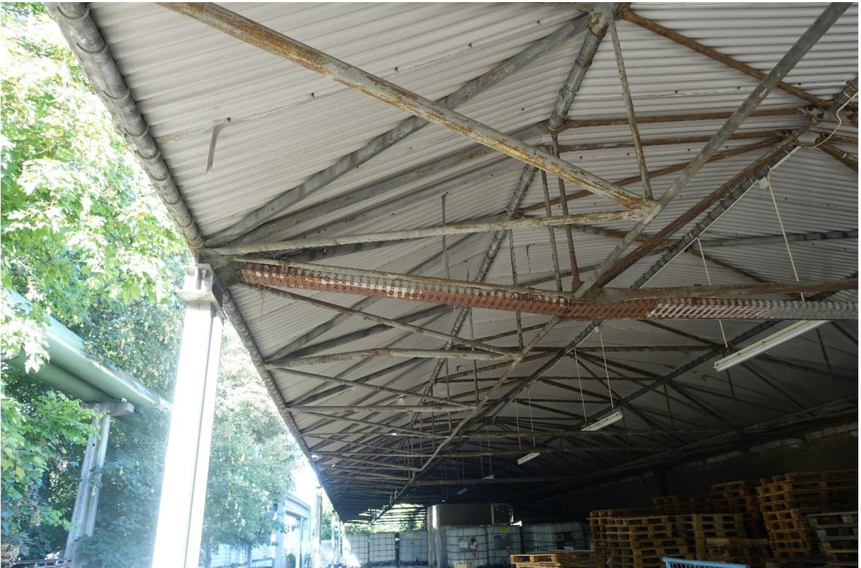
Abb. 6: Das erste Stahlleicht-Raumtragwerk der DDR, der Typ ‚Waren‘ bestand noch aus einer Vielzahl an Stablängen und -querschnitten. Auf dem Bild ein seltenes Original aus dem Jahr 1972 in Leipzig. Foto: Volker Mende, 2021.
