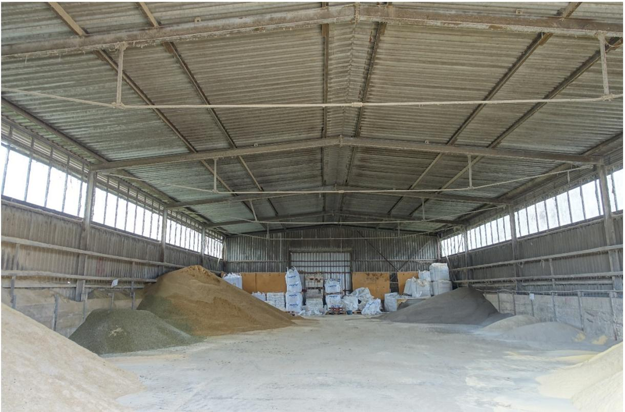
Abb. 19: Diese leichte Landwirtschaftshalle ‚Typ Cottbus‘ mit unterspanntem Vollprofilträger ist nahe von Freiberg in Nutzung. Foto: Volker Mende, 2023.
