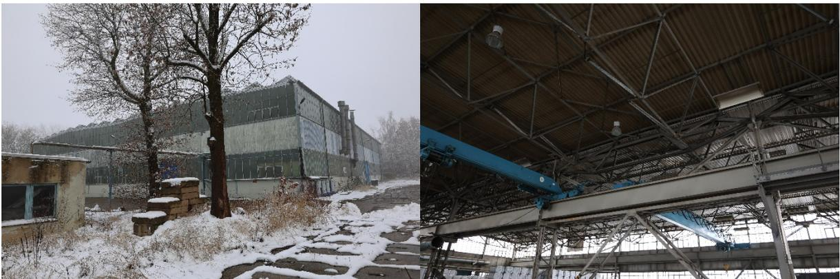
*Abb. 12 und 13: Diese Halle in Mittweida weist das außerordentlich seltene Raumtragwerk ‚Typ Plauen‘ auf, hier jedoch schon die Weiterentwicklung mit ausgekreuzter Querverstrebung zwischen den Obergurten. Foto: Volker Mende, 2023.*
