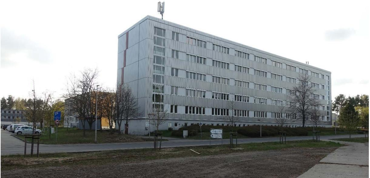
*Abb. 23: Hüllensaniertes ‚Typ Leipzig‘, vormals vom Schweinemastkombinat Eberswalde. Das Beispiel beweist die Tauglichkeit der Konstruktion zur Weiternutzung. Foto: Volker Mende, 2022.*
