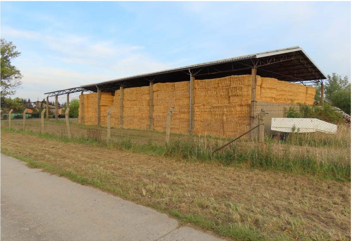
Abb. 5: Der frühe, unterspannte Parallelfachwerkbinder weist eine hohe Anzahl an Kopfsteeben und Pfetten auf. Das Endfeld ist aufwendig verstärkt. Baarsdorf. Foto: Volker Mende, 2023.
