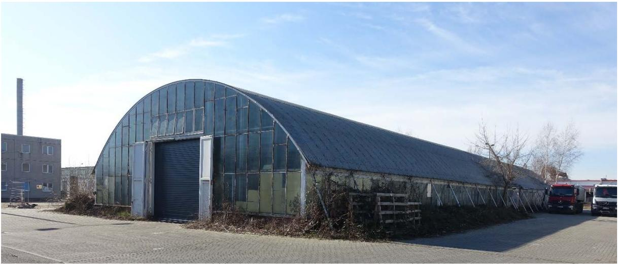
*Abb. 27: Grundbaustein der Sporthalle KT 60 L ist dieser Lagerhallentyp ‚Ruhland‘, eine Stabnetzwerktonne, hier in Magdeburg. Foto: Volker Mende, 2022.*
