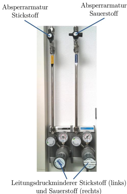
**Abbildung 7-9: Leitungsdruckminderer und Absperrorgane für Stickstoff und Sauerstoff**
