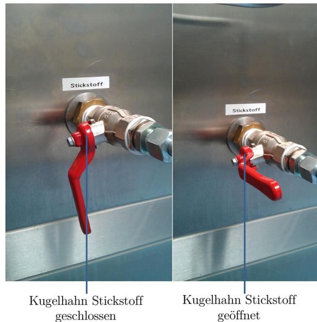
**Abbildung 7-10: Kugelhahn 2**
