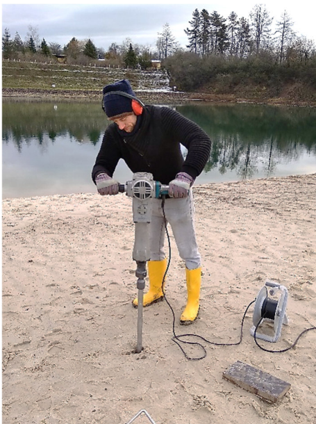
Abbildung 9: Einbringen einer Rammkernsondierung am Strand (eigene Aufnahme)
