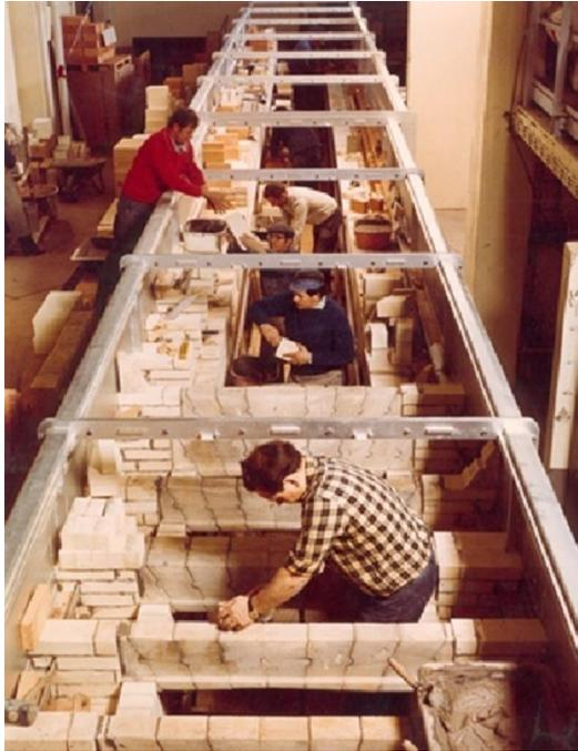
**Abb. 30:** Gewölbe aus Formsteinen im Nut- und Federprinzip
