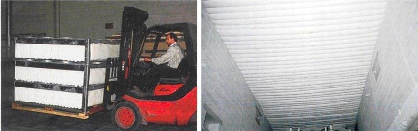
**Abb. 26:** Deckenelemente aus Hochtemperaturwolle [Bec5]
