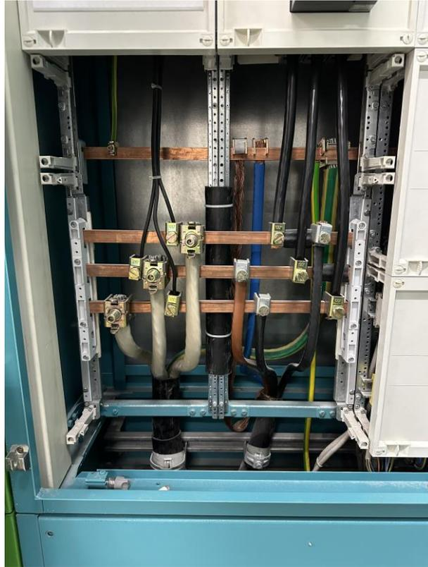
Abbildung 3: Netzanschluss durch Erdkabel NAYY-J 4x70 mm<sup>2</sup>; 3x160A
