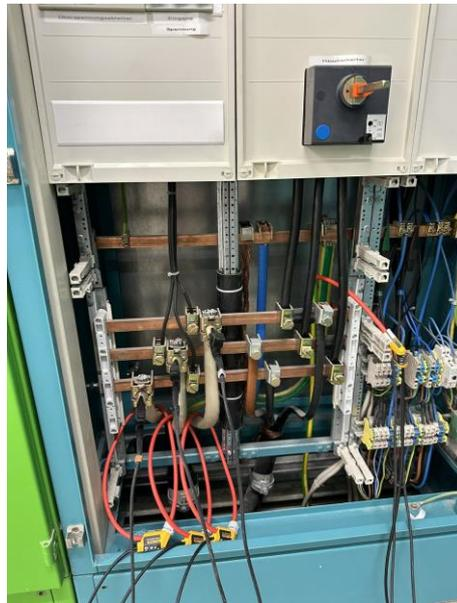
*Abbildung 5: Messung des Lastprofils*
