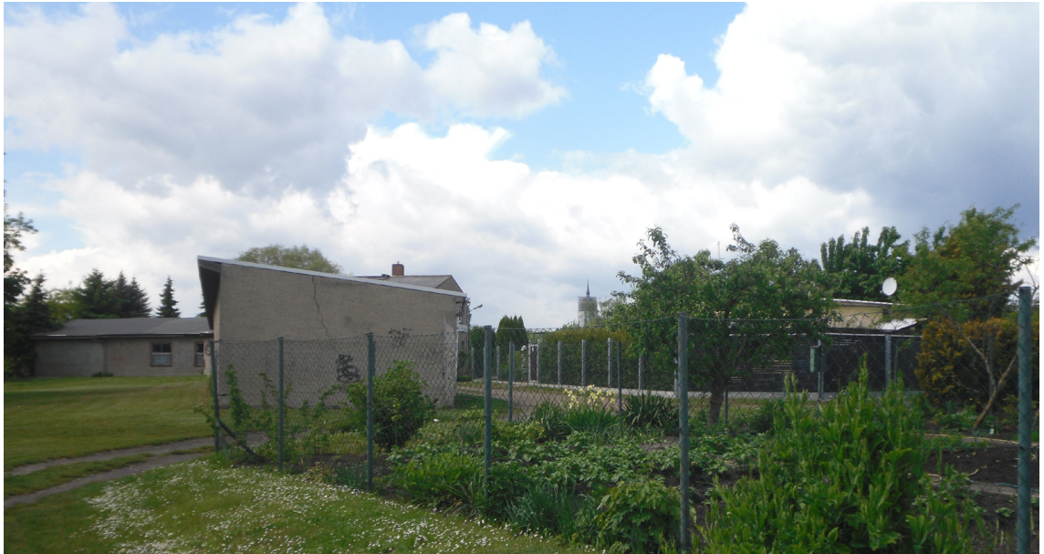
Abb. 83: Blick zur Schlosskirche vom Ende der Kegelbahn - Ostansicht
