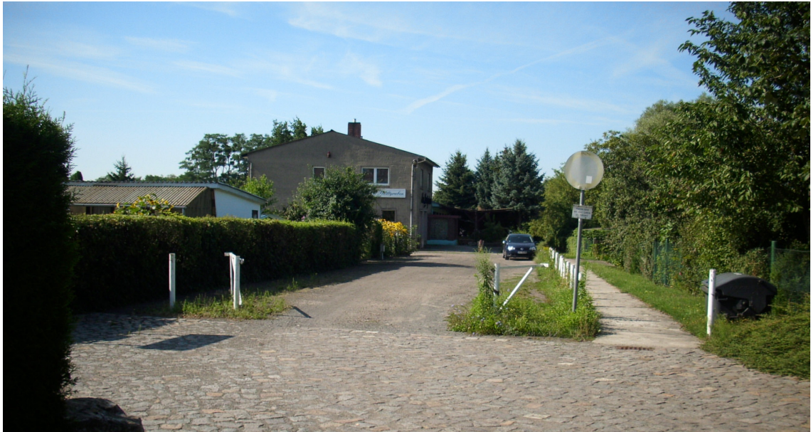
Abb. 47: Breite PKW-Einfahrt und betonierter Fußweg (rechts) führt in die Kleingartenanlage zum Spartenheim
