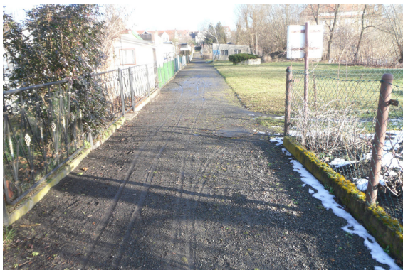
Abb. 80: Kleingartenweg mit Kiesdeckschicht nahe dem Zugang an der Weserstraße
