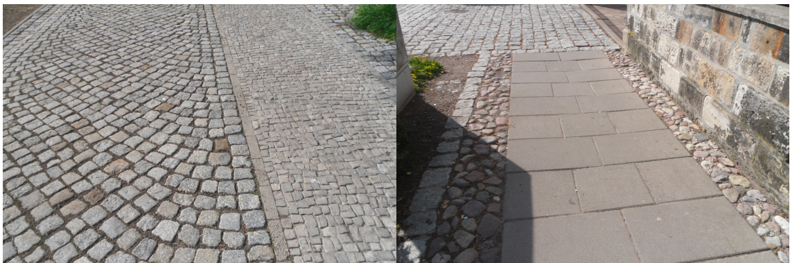
Abb. 78: Altstadtpfaster (links) und Mosaik Kalksteinpflaster (rechts) am ehemaligen Gesundheitsamt Abb. 79: Fußweg aus Betonplatten und Feldsteinpflaster Kanten
