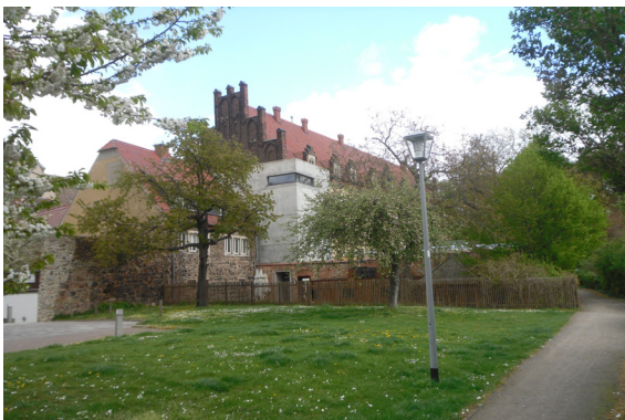
Abb. 90: Blick zum Lutherhaus nahe des Hotels „Best Western“ an der nördlichen Plangebietsgrenze
