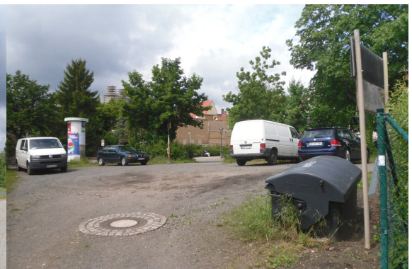
Abb. 105: Streusandbehälter und Abwasser Kontrollschacht am Haupteingang der Kleingartenanlage
